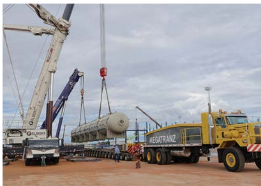
Megatranz: responsável pelo transporte do Balão da Caldeira, de Santos até Inocência, sobre linhas de eixo
