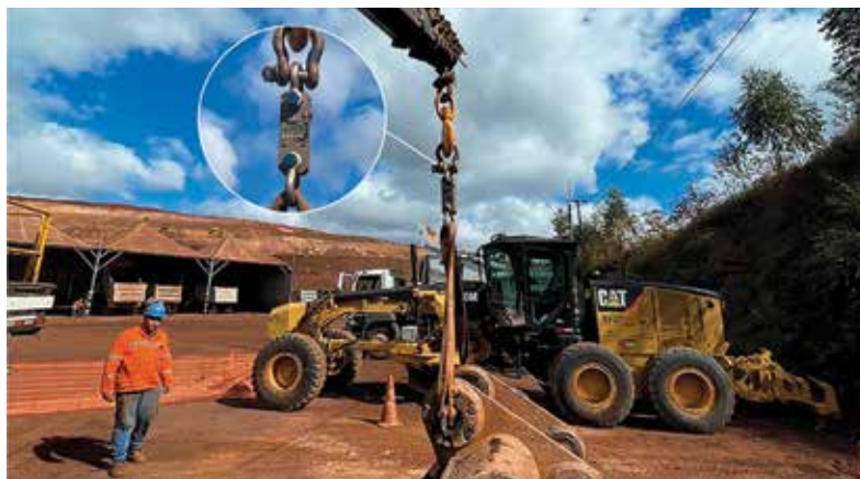
Figura 2. Aplicação do Dinamômetro no Guindaste Articulado
