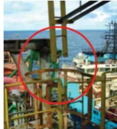
**FIGURA 2 - Interferência entre escadas**
