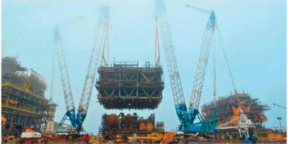
O plano de rigging para essa atividade complexa foi moldado pela diversidade dos desafios encontrados. A presença de obstáculos entre os módulos da plataforma restringiu as opções de posicionamento dos guindastes Manitowoc 18.000 MAXER, adicionando um nível extra de complexidade à tarefa.
