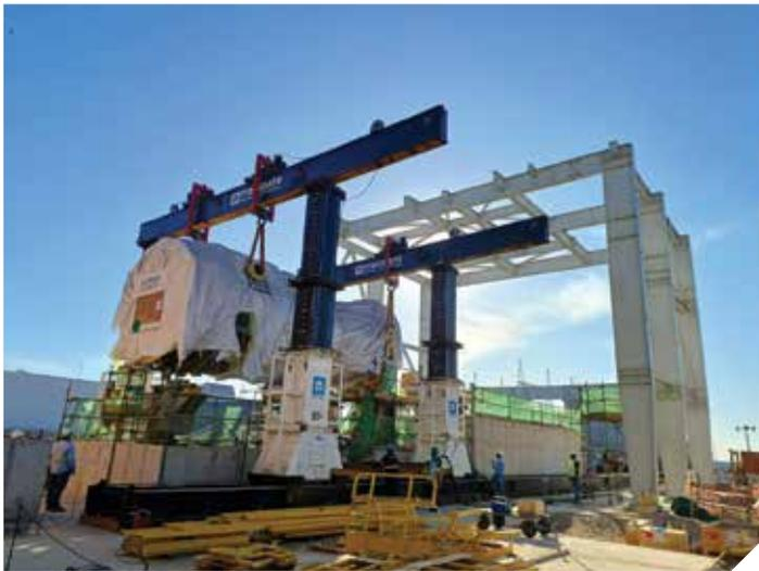
mentação de transporte, a partir do recebimento no costado do navio, foram disponibilizadas 72 linhas de eixo [quatro conjuntos de linhas de eixo autopropelidas SPMT + PPU].
