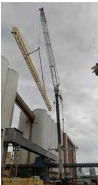
minucioso, da logística de entrega das vigas (38,0m x 2,63m x 6,54m e peso de 17,0 t) até a execução precisa da instalação, a 71,85 m de altura, sem margem para erros. A expectativa técnica estava nas operações de içamento e fixação das vigas, onde deve haver uma coordenação precisa entre guindastes, equipamentos de soldagem e a equipe. Bem como na escolha e aplicação de métodos de fixação que atendam a padrões de segurança estritos, com integração perfeita à estrutura existente.
