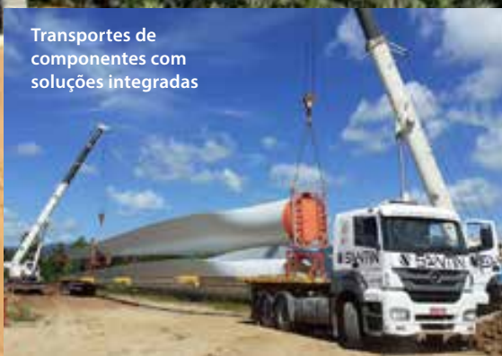
Operação da Santin em parque eólico na Região Nordeste
