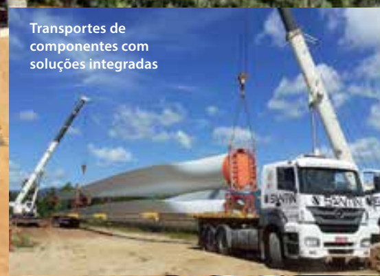
Operação da Santin em parque eólico na Região Nordeste
