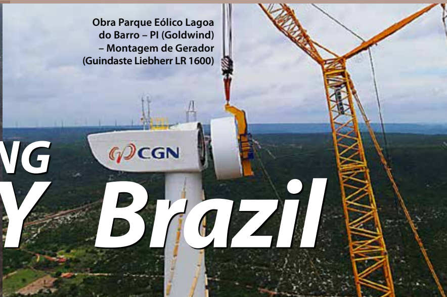
Obra Parque Eólico Lagoa do Barro - PI (Goldwind) - Montagem de Rotor (Guindaste Liebherr LR 1600)
