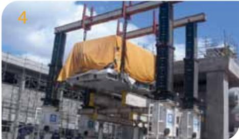
**4** GDK Canoas - Içamento com utilização de Pórticos, projeto de ampliação de Termoelétrica.
