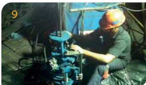
**9** Anel de Vento / Arcelor Mittal - Substituição de Anel de Vento e Gôndola de Auto Forno, utilização de Strand Jacks.
