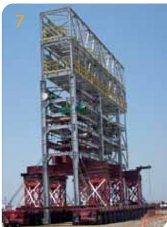
**7** CPPR - Movimentação através de Linhas de Eixo Autopropelidas dos módulos de pipe rack no COMPERJ.
