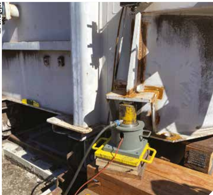
Monitoração das forças de tração para evitar sobrecarga no guincho durante deslocamento horizontal
