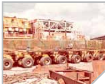
Desmontagem dos equipamentos após término da operação (1982)
