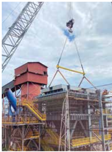
Figura 4. Içamento com cintas têxteis de 2 pernas. Cada uma das 4 cintas tem CTM de 80 t.
